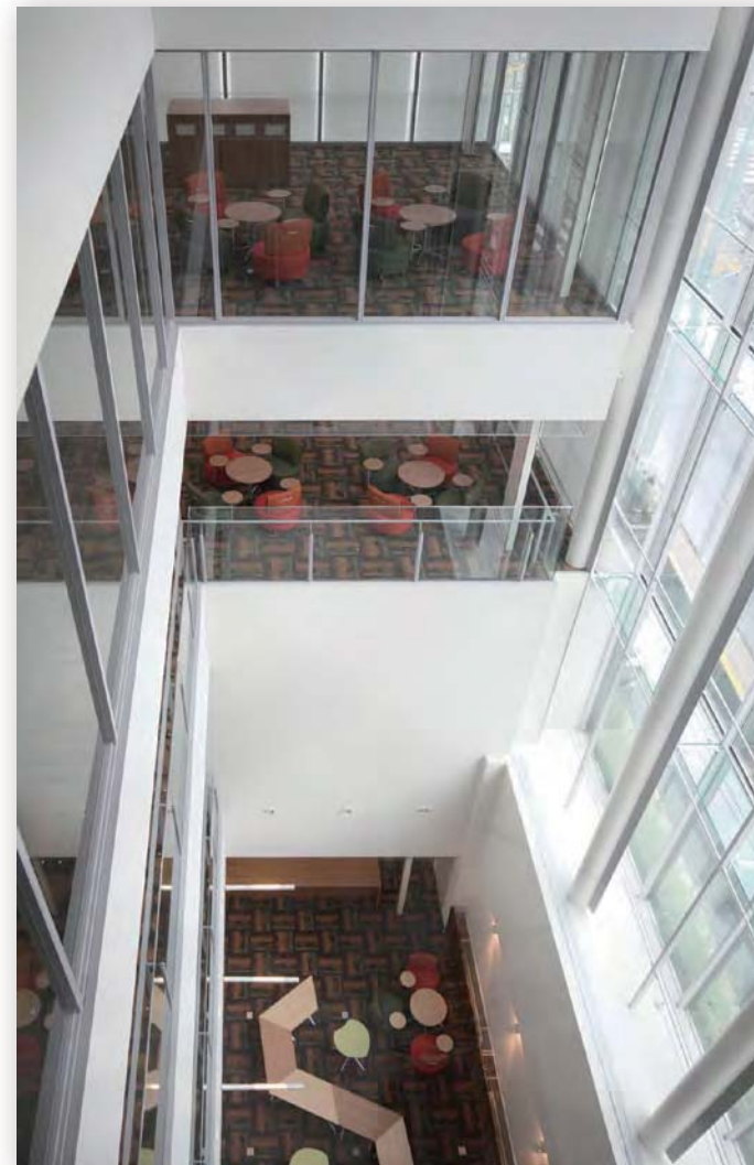
●ガラスカーテンウォールと吹き抜け 執務室に自然光を取り込むだけでなく、どの位置からも空や外部の緑を感じることができ、開放感を演出している。またコラボレーションエリアや階段室もすべて見通せる構造であるため、アイコンタクトやさまざまなコミュニケーションが吹き抜けを通して行われる。
