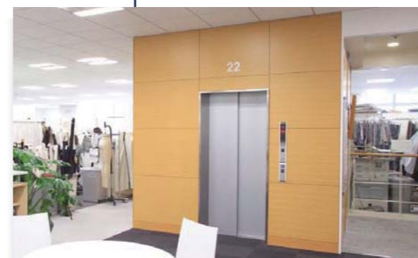
内部専用エレベーター あまり前例がない「内部専用エレベーター」。見本や製品を運ぶことが多い会社ならではの必需設備である。
