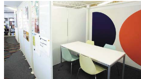
② 吸音板を活用したミーティングルーム。
