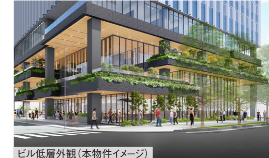
ビル低層外観(本物件イメージ)
