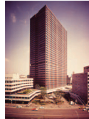
1968年竣工直後の霞が関ビル外観
