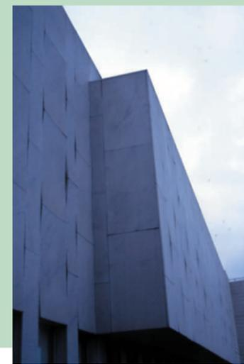
フィンランディアホール(1971年)の外装大理石の置換アールト設計の名建築も、外装の大理石全体にそりが生じるという重大な欠陥が発生した。(写真) その結果オリジナルの大理石は、サイズを変更した新しい同種の大理石により、全面置換されることとなった。(2000年改修工事完了)
