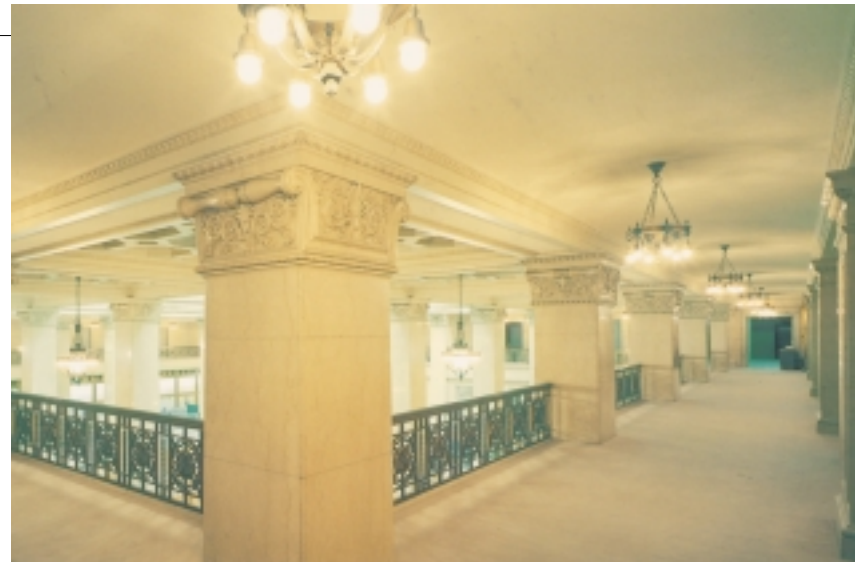
美しい曲面を備えた天井が印象的な二階回廊。 柱頭部の装飾部分に横長の彫刻を配することで、均整のとれたプロポーションを保っている
