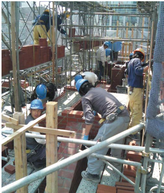
煉瓦積み作業の風景。職人の経験年数がヘルメットの色でわかるようにした。経験の長い職人は、人の目に触れる機会が多い外壁を担当している。
