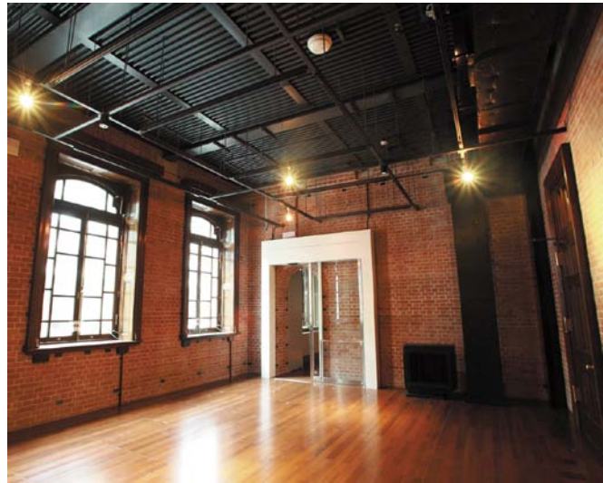
1階ミュージアムショップ。当時は、漆喰で仕上げていたが、この部屋ではあえて煉瓦を見せている。ちなみに窓ガラスは、新丸ビルが竣工当時使用していたものを再利用している。
