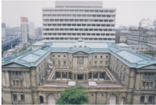
日本銀行本店本館の全景。後方に10階建ての新館が見える
