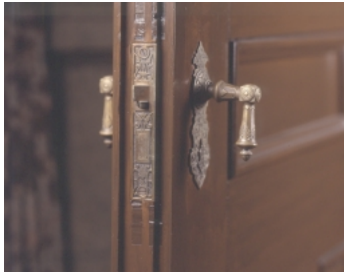
繊細な彫刻が施されたドアの金具。再現不可能のため、 後に補修された部分からはそれが失われている
