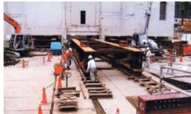
仲通り方向へ1.2メートルの曳家を実施した
