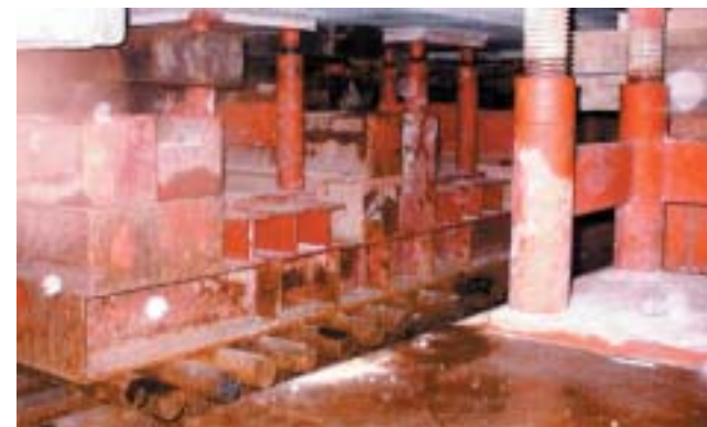
床下に仮受けの鉄骨梁を差し込む
