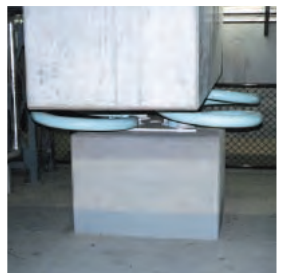
「免震レトロフィット法」を採用した免震装置。必要な耐震性能を持たせながら、建物の外観や内部意匠の改変を最小限に抑えることに成功した。
